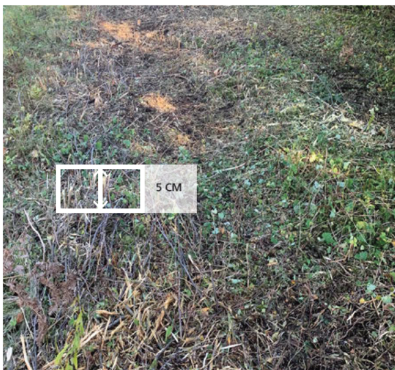
La hauteur des souches doit être de 5 cm.
