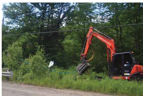
Déboisement sélectif réalisé avec la machinerie.
